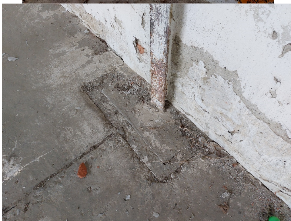
Fotografije 6 i 7 – glavni stup okvira i njegov spoj na temelj
