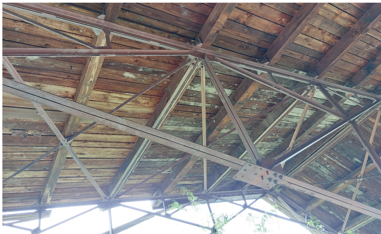
Fotografija 5 – spojevi na rešetki, krovni „X“ spreg, spoj drvenih greda na rešetku
