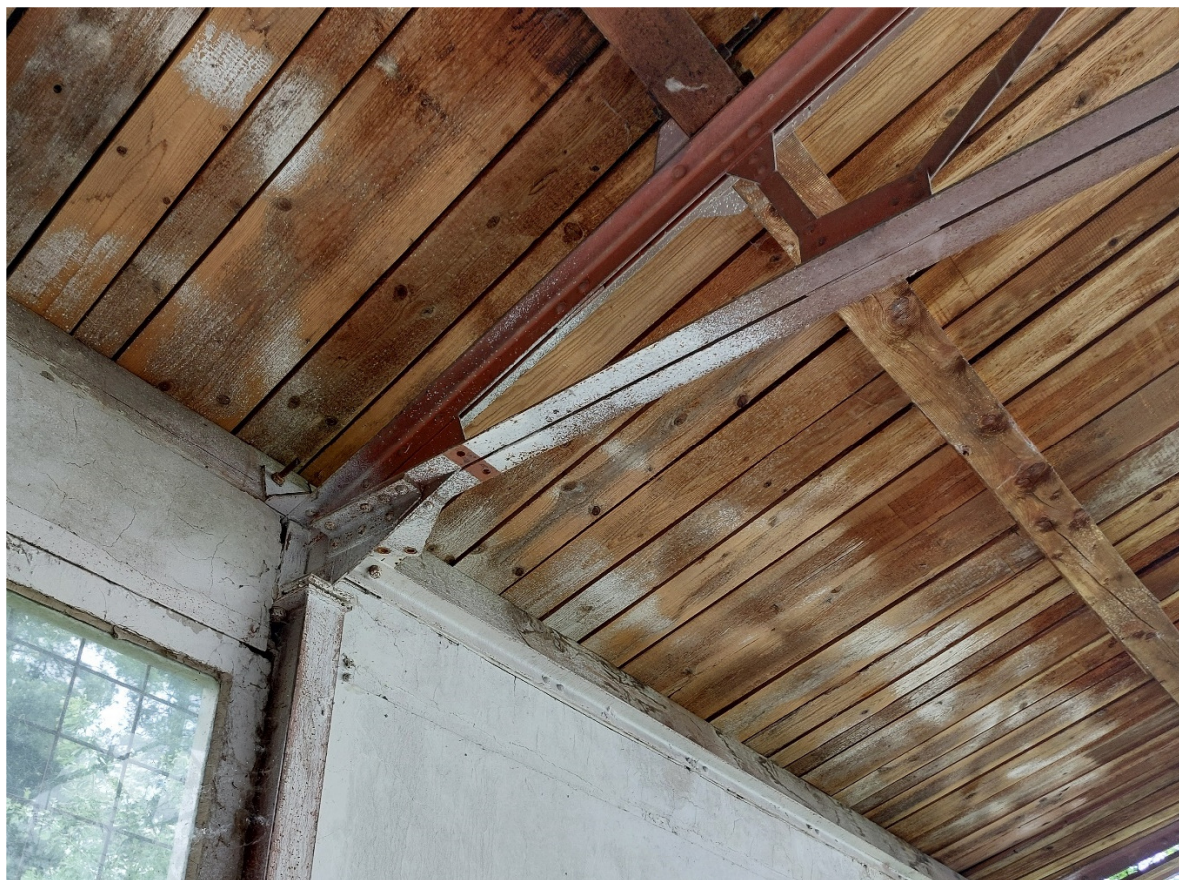
Fotografija 4 – spoj rešetke i stupa
