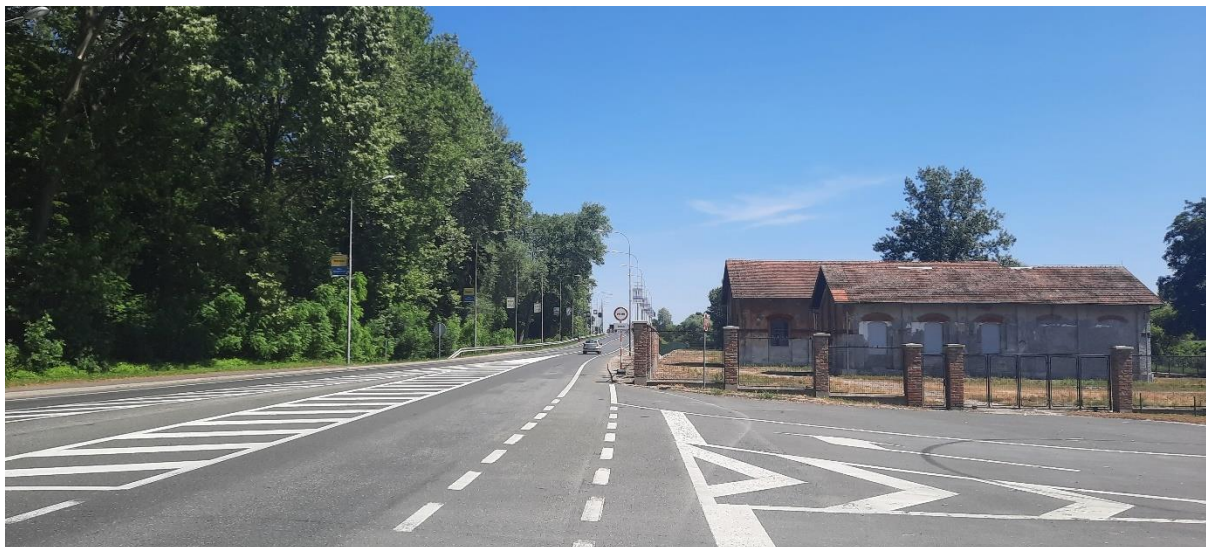
Fotografija C-1: Pogled sa zapada na napuštene industrijske građevine kod stacionaže 0+800
