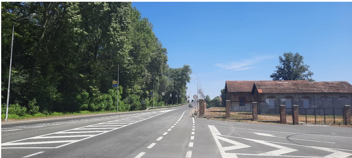
Fotografija A-2: Lokacija postojećeg mosta – pogled s juga
