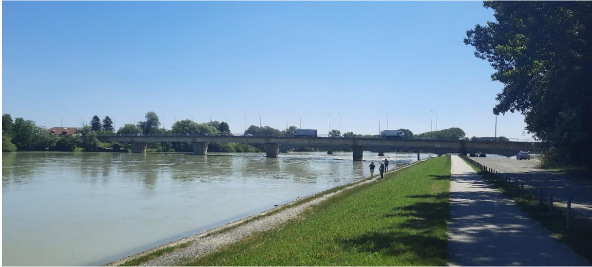
Fotografija A-3: Lokacija novog mosta – pogled sa zapada (zapadno od postojećeg mosta)
