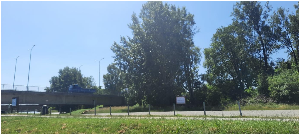
Fotografija A-4: Lokacija novog mosta – pogled prema jugu na prostor početka novog mosta
