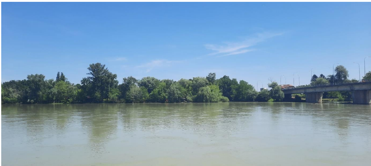
Fotografija A-5: Lokacija novog mosta – pogled sa jugozapada na prostor kraja novog mosta
