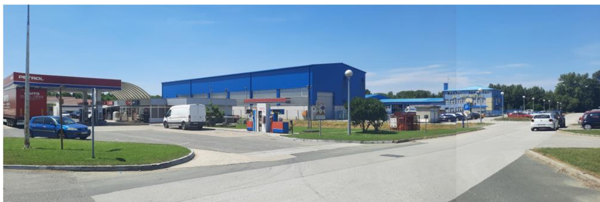
Fotografija C-15: Pogled s ceste na industrijski kompleks sa zapadne strane ceste kod stacionaže 2+400
