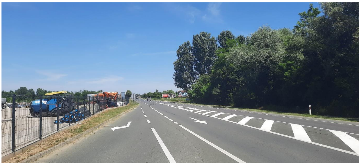
Fotografija A-10: Završetak zahvata (planirani južni krak rotora u području Gornji Kuršanec) – pogled s jugozapada
