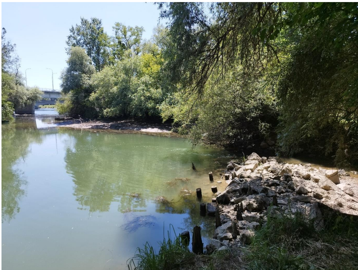
Fotografija C-7: Uvala (Dabrova uvala) u šumi na sjevernoj obali rijeke Drave sa zapadne strane mosta neposredno uz zahvat od stacionaže 1+250 do 1+350 – pogled iz uvale prema mostu
