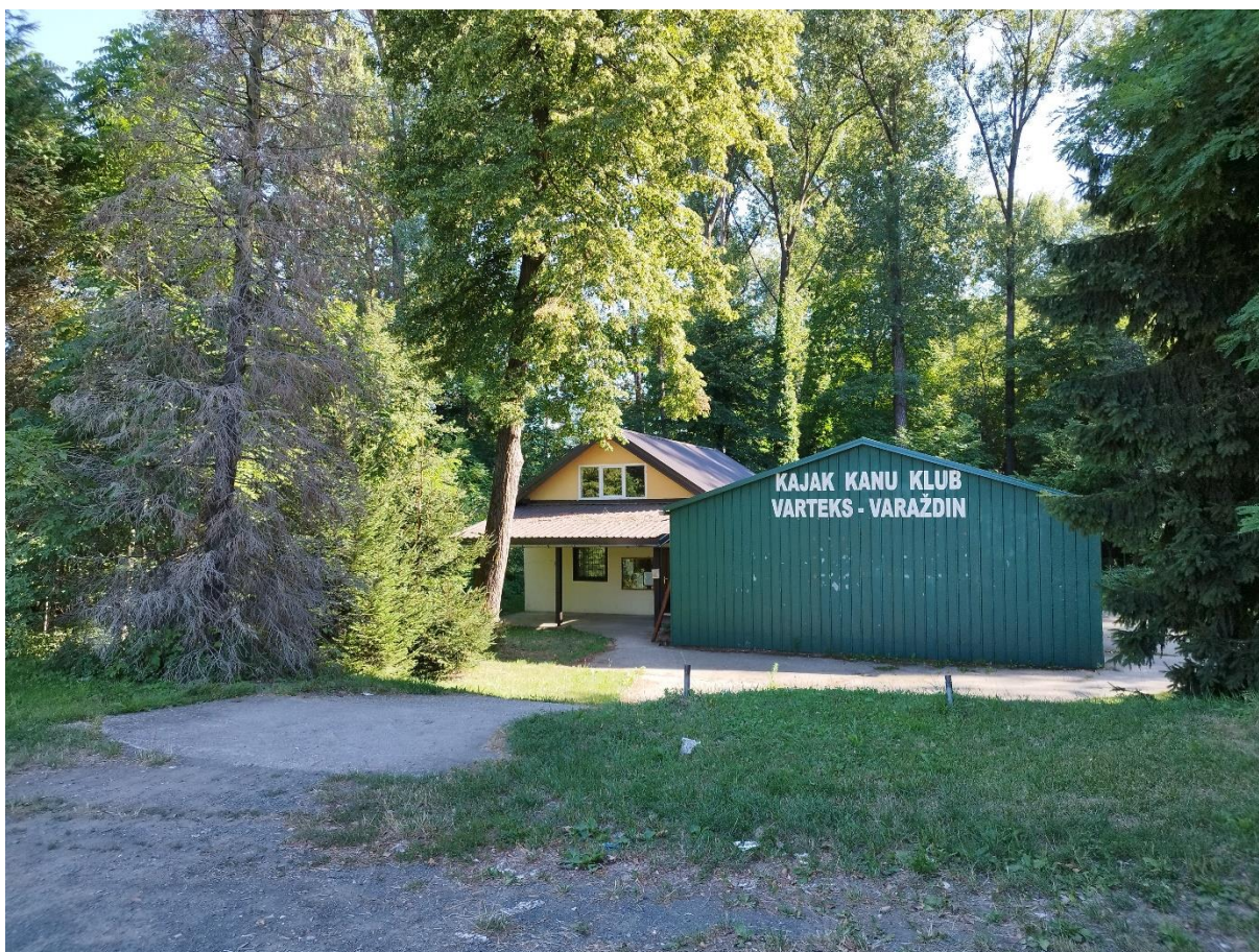
Fotografija C-4: Pogled sa sjeverne strane na objekt kajak kanu kluba „Varteks“ 24 m zapadno od zahvata kod stacionaže 1+020
