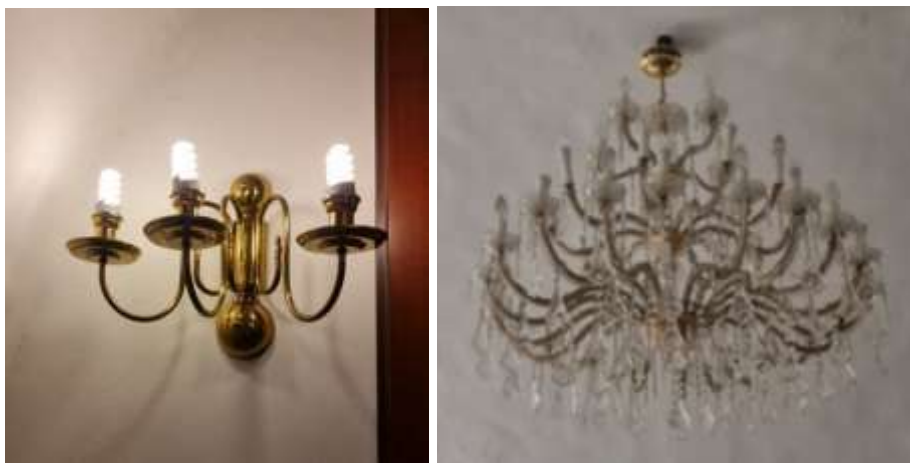
Slika 3 – Postojeća rasvjetna tijela koja se zadržavaju a mjenja se izvor svjetla - sijalice
