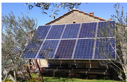
Postavljanje na tlo
