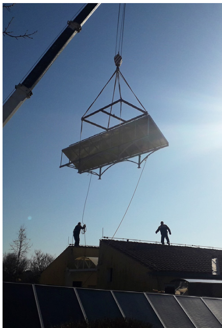
Instalacija u tijeku
