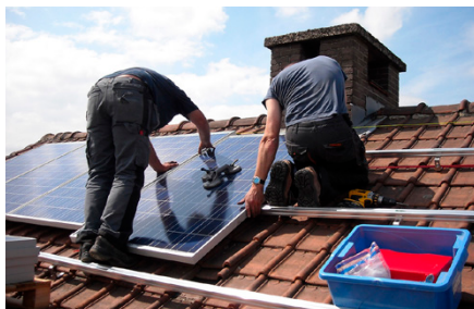
Postavljanje na montažnu šinu
