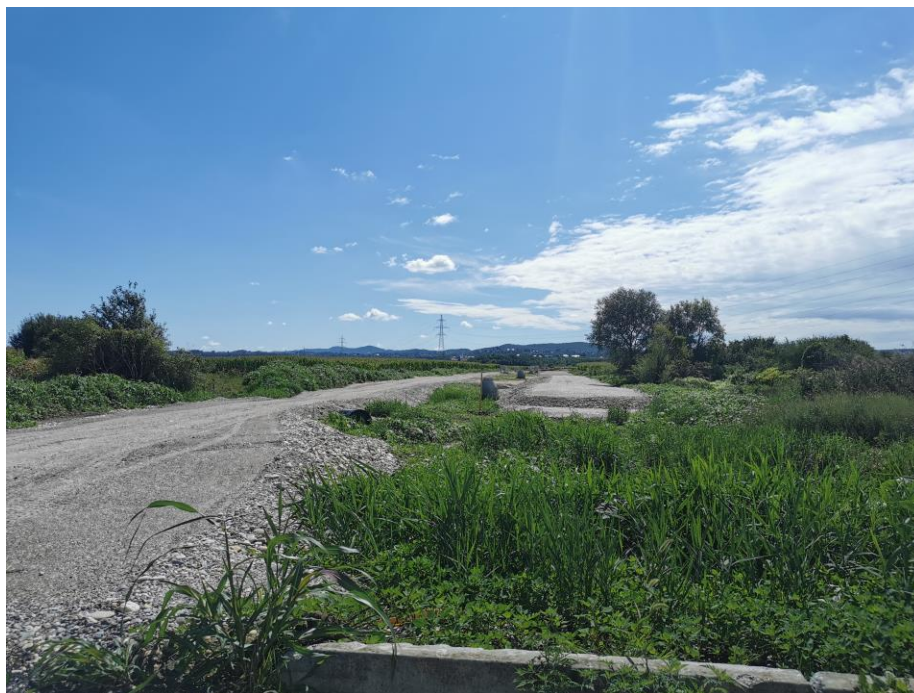
Slika 2 Izrada nasipa južne prometnice
