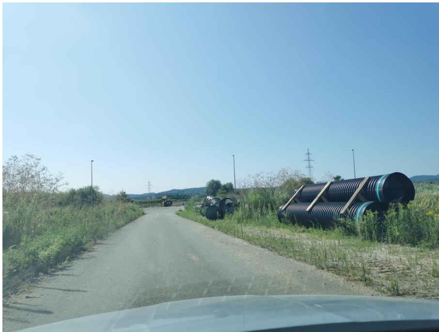
Slika 1 Dobava cijevi na gradilište
