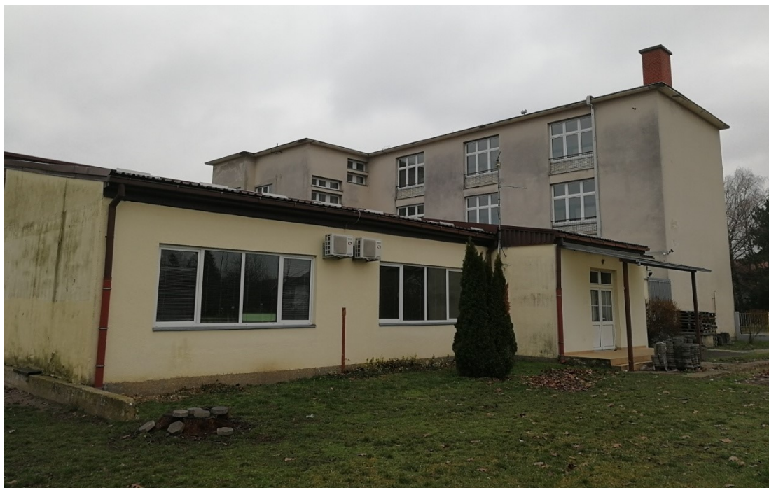
Slika 3: ZGRADA V. OSNOVNE ŠKOLE VARAŽDIN – Ulica Frana Kurelca 11/1, Varaždin Zapadno pročelje
