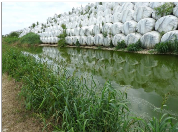
Slika 7. Procjedne vode na lokaciji
