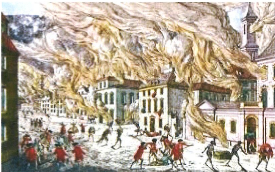
Slika 6. Požar u Varaždinu 25.04.1776.g.
