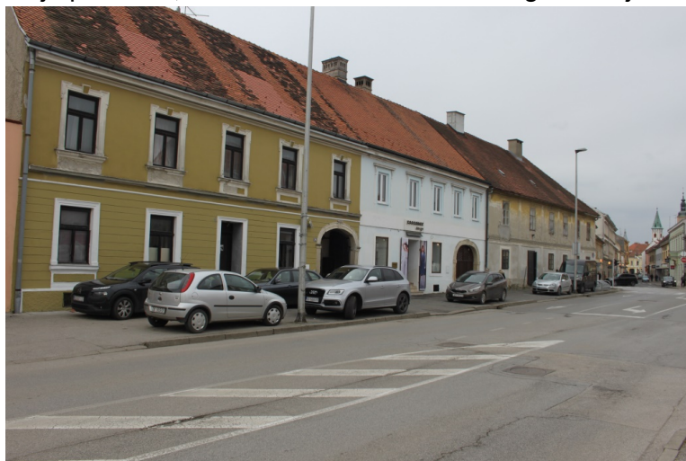
Slika 11 – lokacija 8: Ulica Ivana Kukuljevića (od Ulice P. Preradovića do Ulice O. Price)
