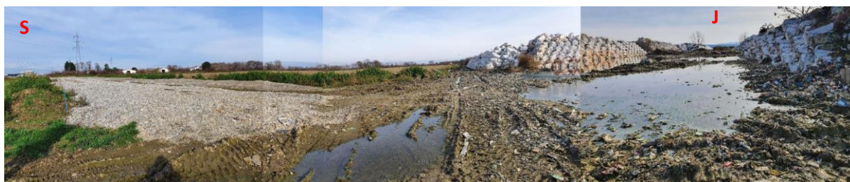
Slika 26. Pogled na trenutnu fazu izgradnje servisne ceste (pogled S-J) i koridor u kojem je uklonjen otpad (izvor: EcoMission d.o.o., slikano 19.11.2021. godine)
