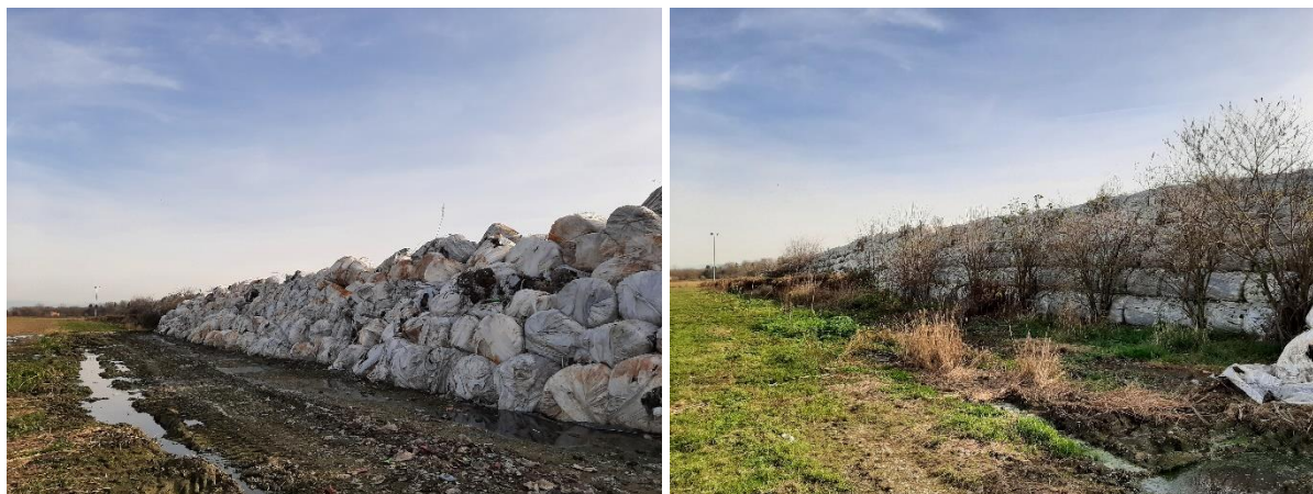
Slika 36. Područje sjevernog djela uz blokove 10, 11 i 12 gdje su depresije zatrpane otpadom i područje zapadne strane blokova s obraštenim depresijama u kojima se povremeno zadržava procjedna voda (izvor: EcoMission d.o.o., slikano 19.11.2021. godine)
