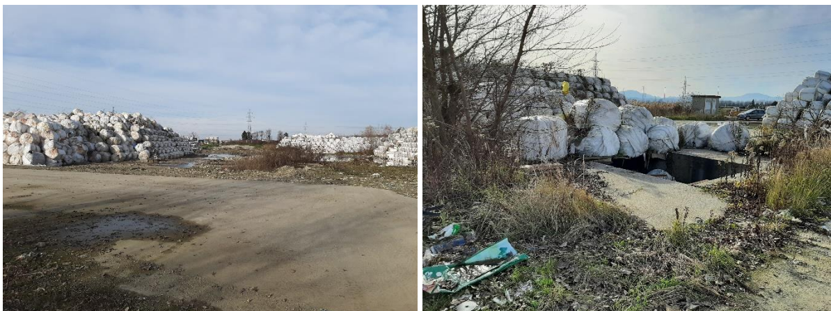
Slika 35. Dijelovi građevina koja će se rušiti i uklanjati (asfaltne i betonirane plohe i prometnice, betonska sabirna jama)
